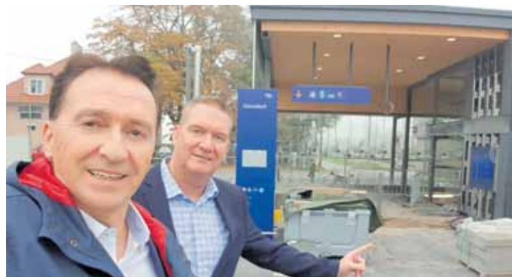
Bürgermeister Alexander Vojta und Gemeinderat Hans-Jürgen Peitzmeier überzeugten sich vom Baufortschritt am Bahnhof Gerasdorf.
